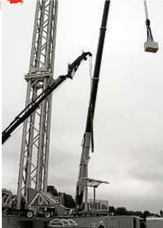
Vorbereitung auf das Vogelschießen in Rudolstadt: Gestern hat der Aufbau des 80 Meter hohen City-Sky- liners begonnen. Foto: Heike Enzian
